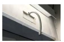
Fig. 5.3.21. Flexible Metal Conduit (FMC)
