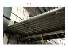
Fig. 5.3.19. Rigid Metal Conduit (RMC)
