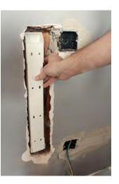
Fig. 7.1.4. Fixing of conduit in wall
