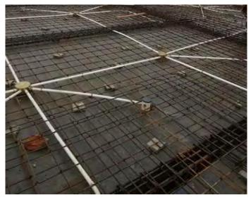
Fig. 7.1.1. Concealed Conduits in Slab
