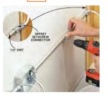
Fig. 7.1.7. Procedure for open conduit wiring
