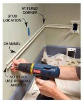
Fig. 7.1.8. Fitting open conduit on wall
