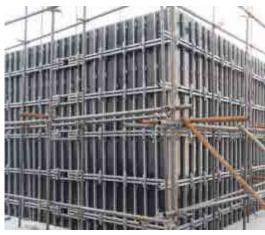
Fig. 4.3.27. Formwork
