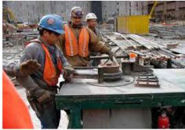
Fig. 4.3.11. Cutting of Rebars
