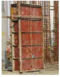
Fig. 4.3.10. Column formwork
