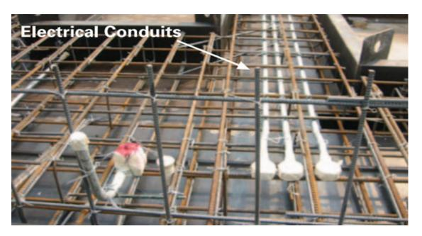
Fig.4.4.12. Adding Electrical Conduits
